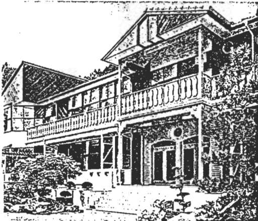
正面玄関。バルコニー梁と玄關ポーチの柱材は杉の集成材。外壁は檜杉板。
