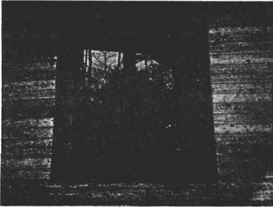
写真-7 カラマツの木製サッシュと壁板
