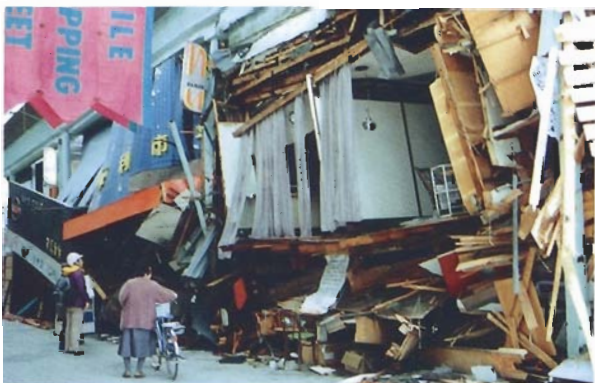
写真4.2.65 同上。写真中央やや左にメインストリートに直交した小路があった。この区画は30年くらい以前に火災があり、その残材を使用していたとの話である。腐朽・蟻害は著しい。
