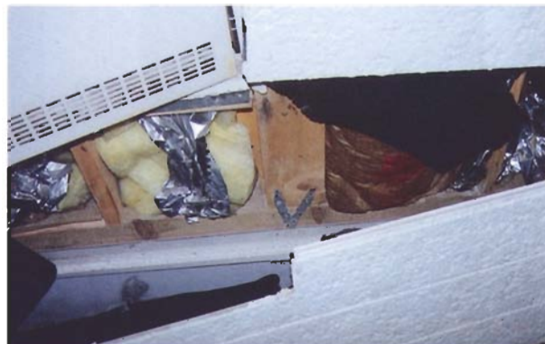
写真4.2.36 同上。1階土台近傍。土台ベイツガCCA、健全、MC9、柱ベイツガ100mm角、健全、MC12、筋かいベイツガ42×83mm。金具使用。
