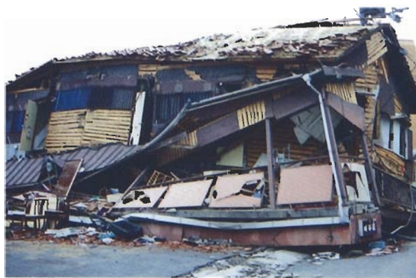
写真4.2.26 木造アパートの典型的な倒壊例。1階全壊。（西宮市桜谷町）
