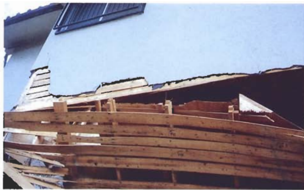
写真4.2.22 同上。1~2階部分。柱類は短ほそ、斜め釘打ち、壁は木ずり、モルタル仕上げ、ここでは筋かいは見えない(他の部分では25×90mmのところあり)
