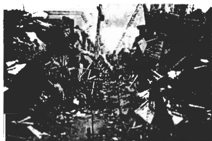
写真4 全体崩壊した木造住宅(長田区)
