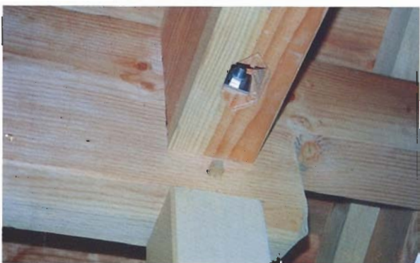
写真4.2.63 下屋部分梁一桁のボルトによる接合の状況。柱一梁はこみ栓止め。横架材はすべてベイマツ。小屋組には火打ちはあるが、内部の梁一桁の接合では金物による補強は少ない。意匠的なものかも知れない。
