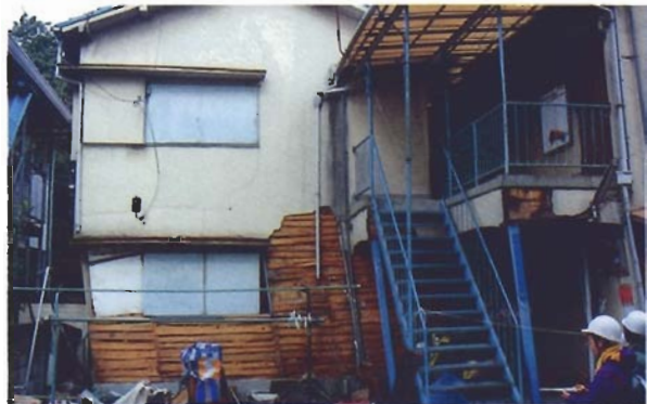
写真4.2.33 同上。土台はヒノキ、水回りのMC30。1Fのθ105/1000。
