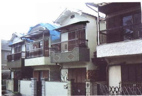
写真4.2.3 間口2間のいわゆるミニ開発住宅。被害は軽微のようである。妻壁あるいは内部間仕切り壁の耐力が有効であったものと思われる。（芦屋市三条町）
