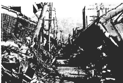
写真5 全体崩壊した木造住宅(灘区)
