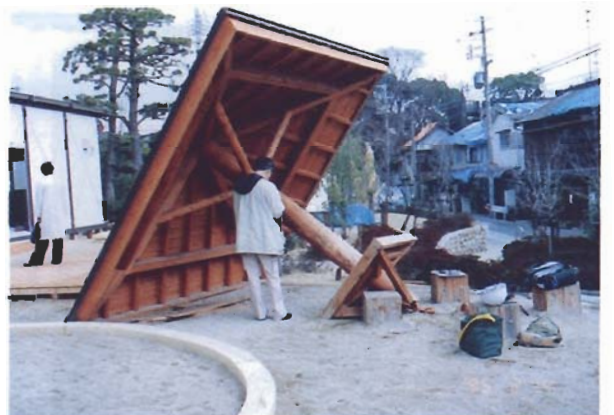
写真4.2.75 同上。一質点系振動モデルを適用し倒壊のメカニズムの結果では構造物の先端付近の加速度応答スペクトルSAの値は2244Galとになった。
