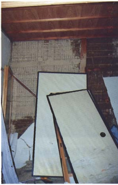
写真4.2.30 同上の内部、間仕切りは土塗り、竹小舞、筋かいなし、柱はスギ、MC12~14、Pe8、健全
