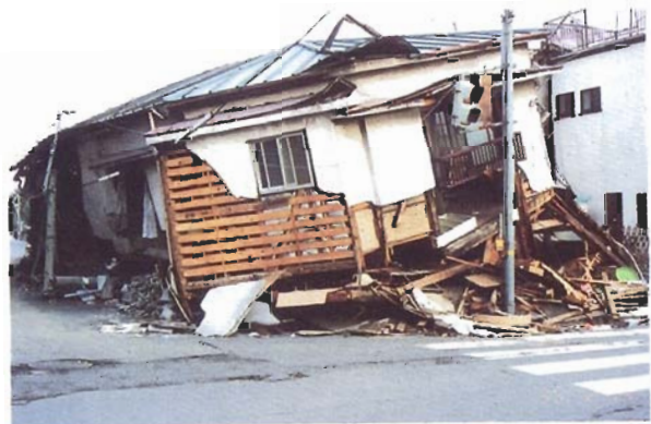
写真4.2.6 2階のみが原形を留めている住宅。部材の腐朽が著しい。（東灘区森南船戸町）
