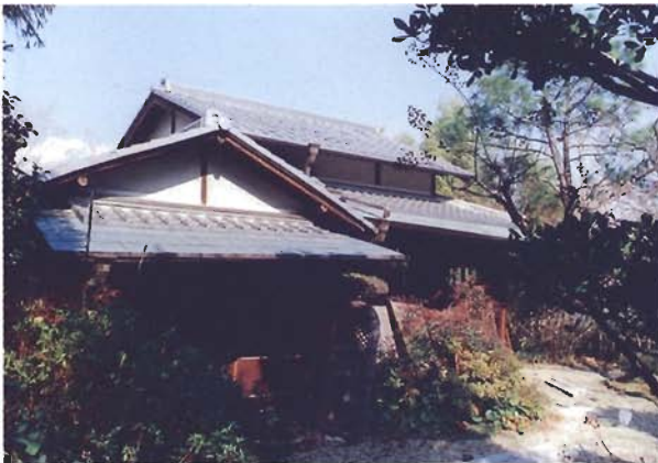
写真4.3.20 東立て式茶室：建物40（宝塚市塔の町・S女子学院内）。戦前の建築で移築したもの（手前の建物）。布基礎、土台のない東立て工法。建物自体には地震動による損傷は少ない。
