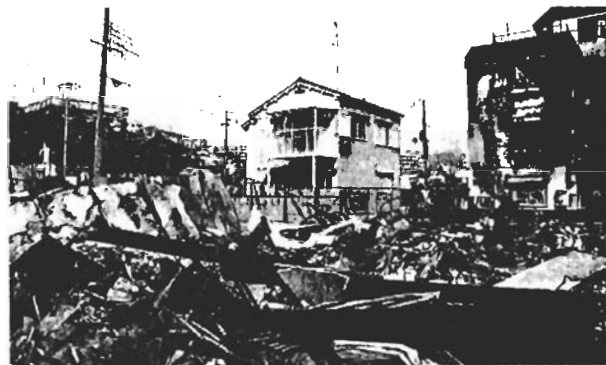
写真9 周囲が焼失した中で、燃え残った住宅。ラスモルタルが剥落しなかった。
