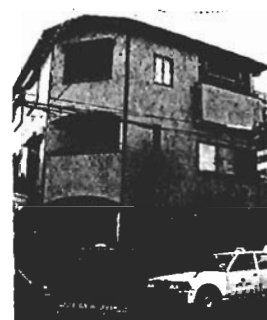
写真24 激震地で被害を受けなかった3階建て在来軸組工法住宅(東灘区)
