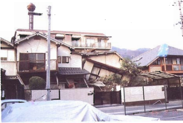
写真4.2.1 在来木造が並んでおり損壊型が異なっている例（東灘区本山中町）
