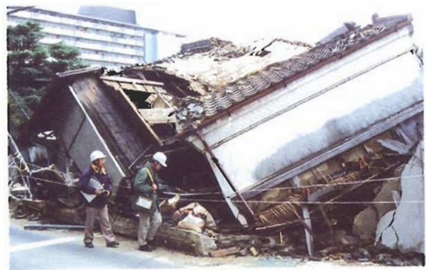
写真4.2.5 全壊住宅。腐朽が著しい。手前は葦。（芦屋市船戸町）
