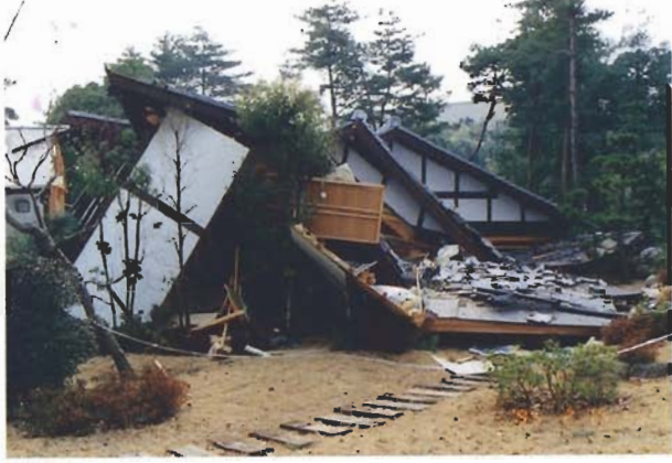
写真4.3.16 集成材／素材軸組構法建物の倒壊：建物38（宝塚市塔の町・S女子学院内）。主屋・下屋とも床下はコンクリート敷設、主屋の床下部材には防腐・防蟻施工、床下には腐朽・蟻害は認められなかった。
