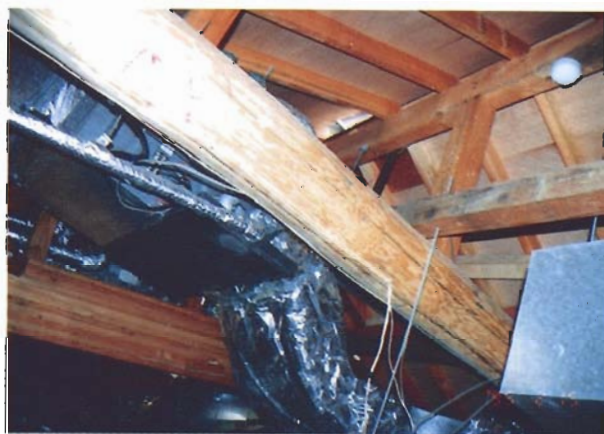
写真4.2.43 同上の丸太梁と集成材梁、母屋、棟木の 取り合い。この写真は8畳間から18畳間の方向を撮 影したもので、奥に見える集成材梁が8畳間と18畳間 の間に入れられた幅16cm、せい40cmの大断面集成材 である。丸太梁が右側に存在していたであろう桁とど のように接合されていたかは確認できていない。
