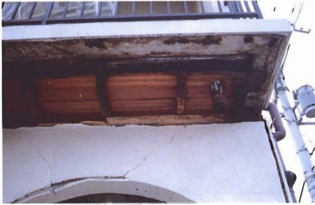
写真4.2.16 No.22-シロアリ被害住宅4棟ミニ開発(東灘区森北町)。玄関、開口部柱、ベランダ床すべて蟻害。土台ベイツガMC10~15。 \theta は10/1000。筋かい細い。柱ベイツガMC10、Pe10。健全。
