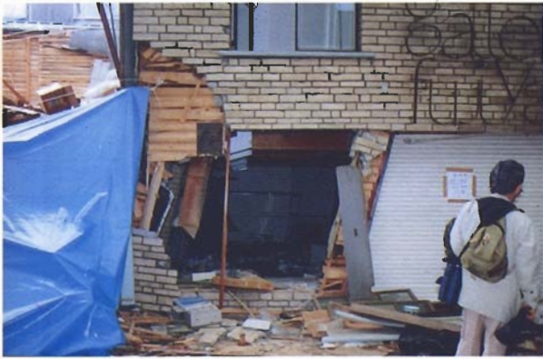
写真4.2.66 同上。土台・柱等は交換しているようで健全。柱ベイツガMC12。θは200/1000。内部の梁はケヤキ。新しい。
