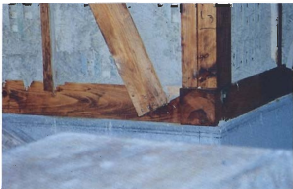
写真4.2.62 同上と同一筋かいの下部。なお、対称的に挿入された筋かいは下部の釘は止まっている。土台回りはしっかりしているようである。
