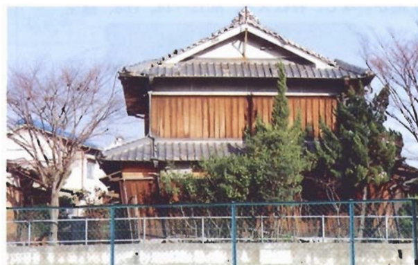
写真4.2.37 倒壊を免れている民家型住宅 (伊丹市池尻)
