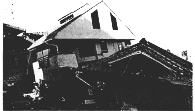
写真5 1階が倒壊した木質系パネル構法住宅。隣の建物に寄り掛かっている
