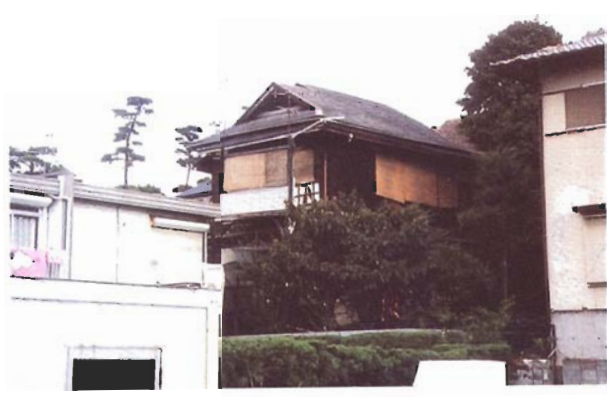
写真4.2.4 倒壊を免れたかなり建築年代の古いと思われる住宅。（芦屋市西芦屋町）
