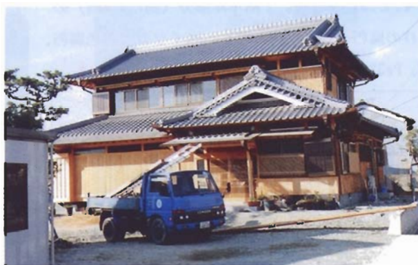
写真4.2.38 一部損壊に留まっている新築民家型住宅 (伊丹市池尻)。手前右隅の柱が土台からはずれていた。
