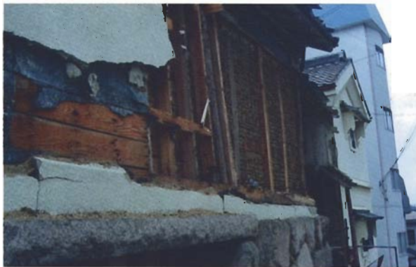
写真4.2.8 同上の裏側。土塗り壁、筋かいなし。くされがかなり進行。塀部材と思われるイエシロアリによる蟻害あり。スギ、MC10、Pe28~32。
