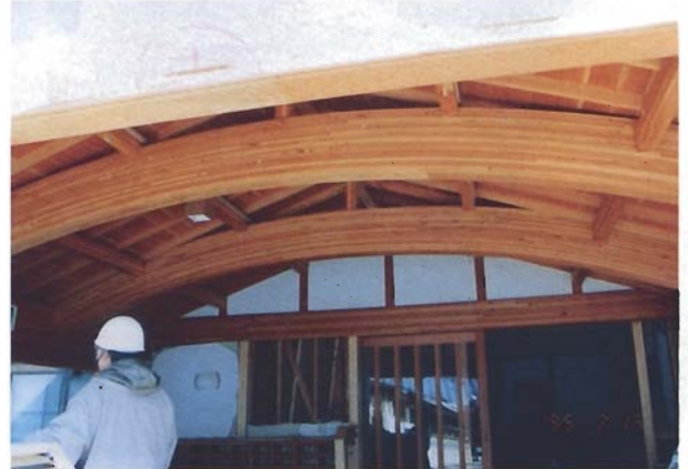
写真4.2.54 玄関部分（No.29）。屋根梁にベイマツ湾曲集成材が使用。損傷はごく僅か、変形も軽微。
