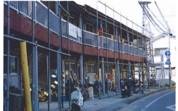
写真4.2.28 被害が少なかった木造アパート（伊丹市池尻）。震度階5以下の地域と思われる。倒壊した木造アパートは、このような外観だったのであろう。なお被害は妻壁はモルタル剥落程度。筋かいあり
