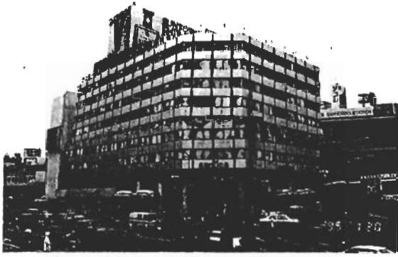
写真2 中間階が崩壊した交通センタービル
