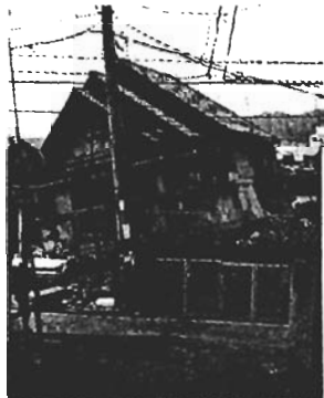
写真13 2階部分(木造の1層目)が倒壊した住宅。1階部分は鉄筋コンクリート造のガレージ(東灘区)
