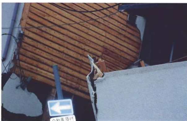
写真4.2.24 2~3階のつなぎ一柱はすべて短ほそ。仕上げは3階のみサイジングなので、3階部分のみ増築か？
