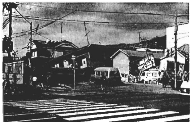
写真3 2階を増築した住宅の倒壊（左側の大きい建物）
