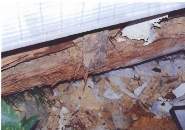
写真4.3.42 モルタル壁の剥落と部材の腐朽・蟻害 : 建物37 (神戸市東灘区本山中町4丁目14、住宅)
