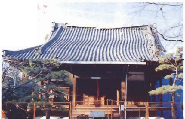
写真4.2.70 昆陽寺(伊丹市寺本)。屋根瓦の移動顕著。構造躯体に目立った損傷はない。
