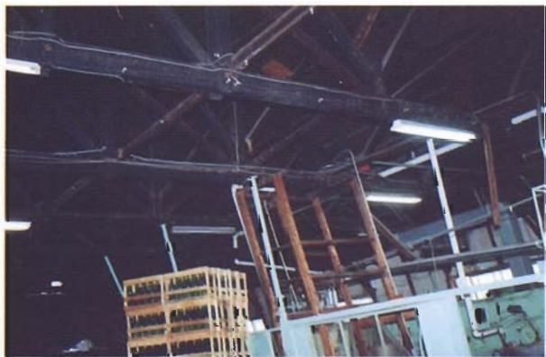
写真4.2.67 同上。トラス材(樹種不明、120×180~240mm)。桁行き方向の壁は土塗り・竹小舞で筋かい。は確認できなかった。
