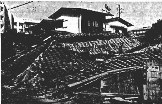
写真7 古い構法の木造住宅の倒壊 (後方の在来構法はほぼ健全)
