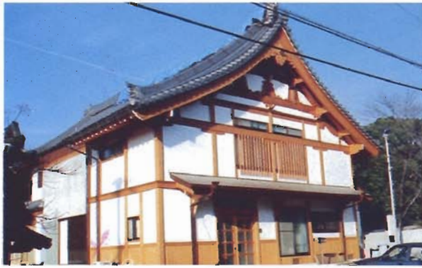
写真4.2.71 同上裏の新築の寺（伊丹市寺本）。壁にわずかの損傷。奥に住居部あり。大断面集成材使用。
