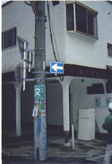
写真4.2.31 No.10。1階車庫部分（間口1.5間）の独立柱の腐朽（西宮市桜谷町）。ベイツガ、褐色腐朽、MC14、Pe32。
