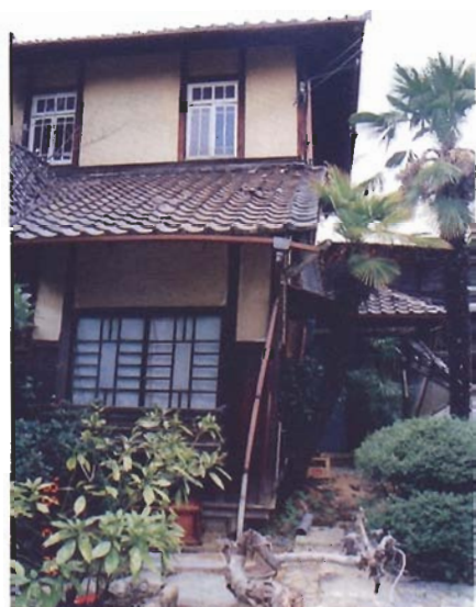
写真4.3.3 一部大壁式の医院兼住宅：建物3（芦屋市業平町6）。真壁造の住宅部分。
