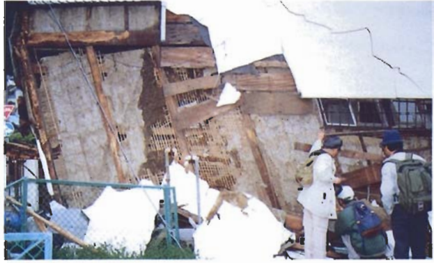
写真4.2.32 同上。電柱で倒壊を免れている。筋かい27mm、間仕切り筋かいなし。壁材シロアリ。柱はスギ。健全部MC12~14、Pe8mm、被害部Pe40mm。土台、シロアリ、比較的健全部MC14~16、Pe12~18
