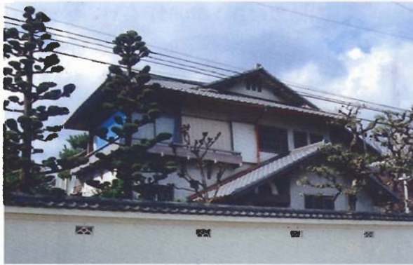
写真4.2.7 同上。玄関側。増改築か?
