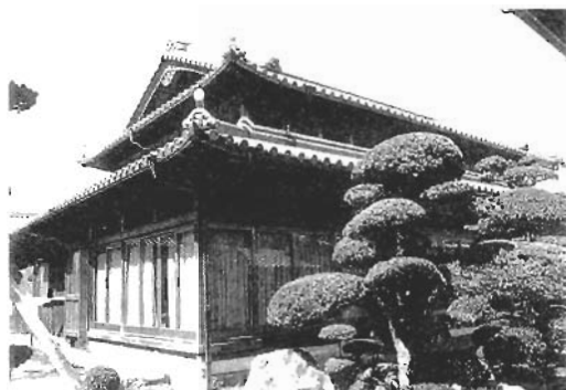
写真6 (左上下) 能登地方民家の伝統工法 「さしもん造り」の吹抜空 間 (石川県志雄町で) 交差した梁を掛け渡すこ の部分が構造の核になる
