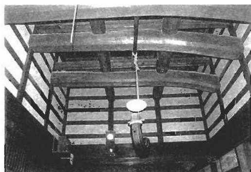
写真6 (左上下) 能登地方民家の伝統工法 「さしもん造り」の吹抜空 間 (石川県志雄町で) 交差した梁を掛け渡すこ の部分が構造の核になる
