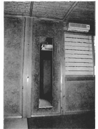
写真2 小舞下地土塗荒壁仕上げの和室(壁面の斑文様は壁土から出た「あく」で、壁土の活性の強さの現れ)
