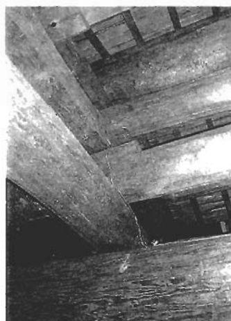
写真6 (左上下) 能登地方民家の伝統工法 「さしもん造り」の吹抜空 間 (石川県志雄町で) 交差した梁を掛け渡すこ の部分が構造の核になる
