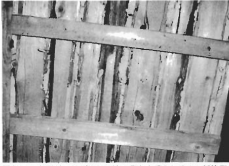
写真1-1 板野地の飛び打ち工法で葺き土垂らし込みの新築例
