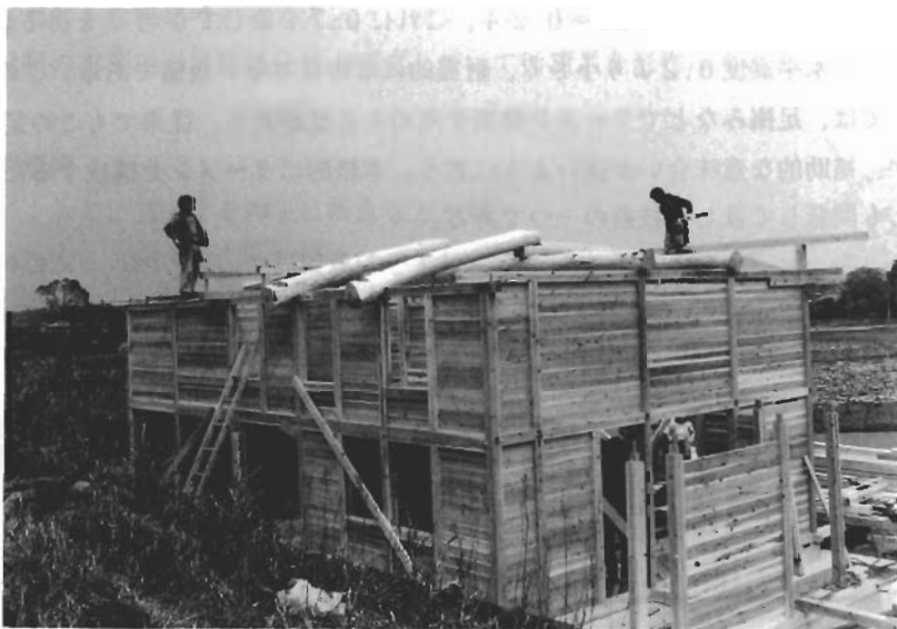
写真1 落とし板壁式住宅
