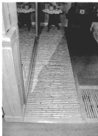
写真5 応接室床の「がらり」
