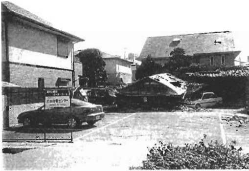
写真1 倒壊した古い住宅と被害のない新しい住宅 (兵庫県芦屋市で)
