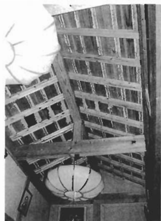
写真7 書斎の天井見上げ(板野地の飛び打ち工法で葺き土の垂らし込み。野地板の間に見えるのは、わら縄を巻いた割竹)
