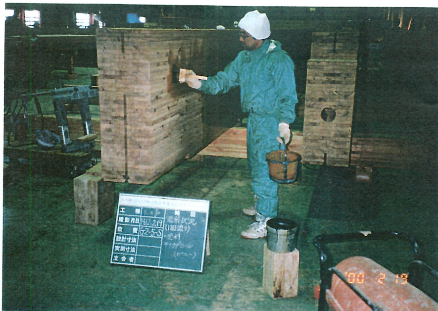
写-3 集成材の塗装
