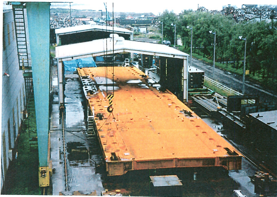
写-16 鋼床版・主桁部材の仮組立
