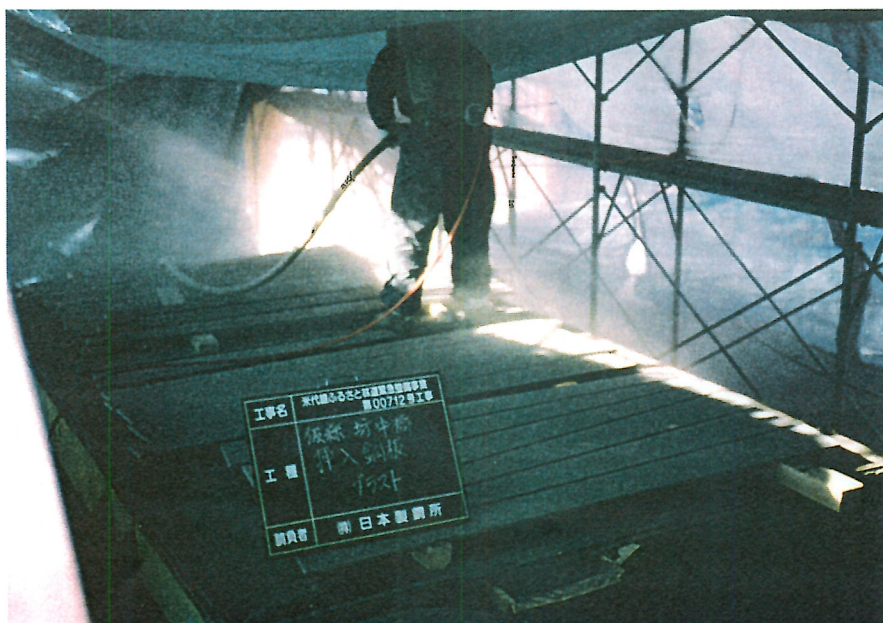
写-10 挿入鋼板ブラスト処理
