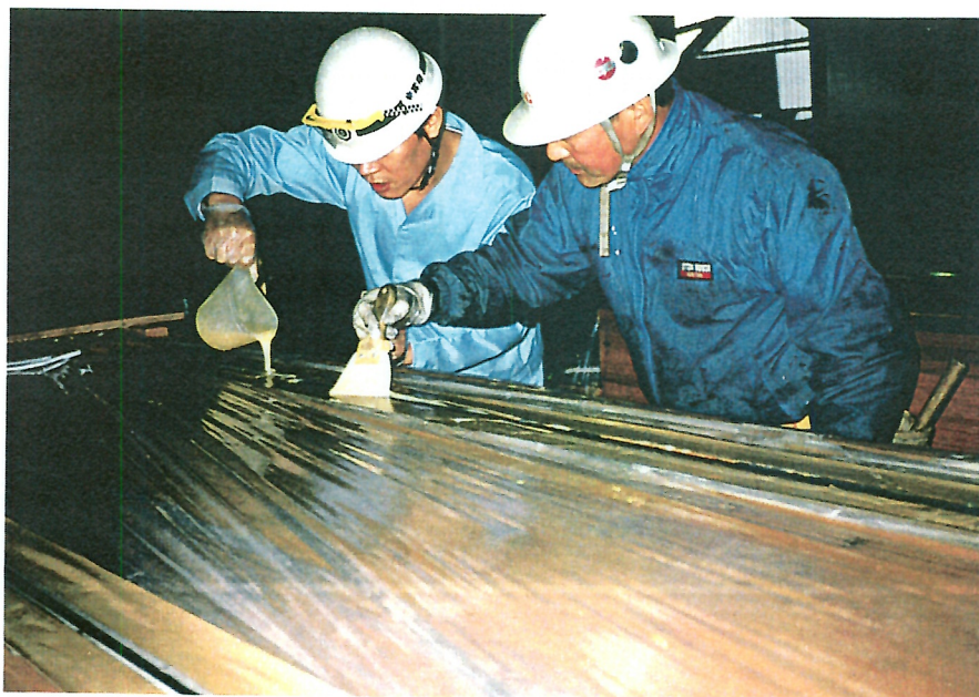
写-11 接着剤の注入
