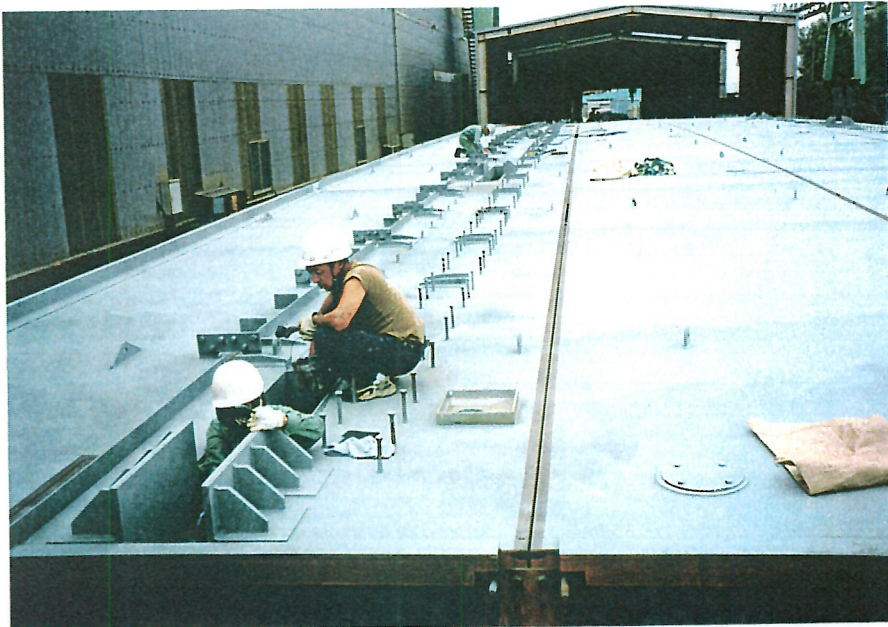
写-18 床版舗装部の塗装
