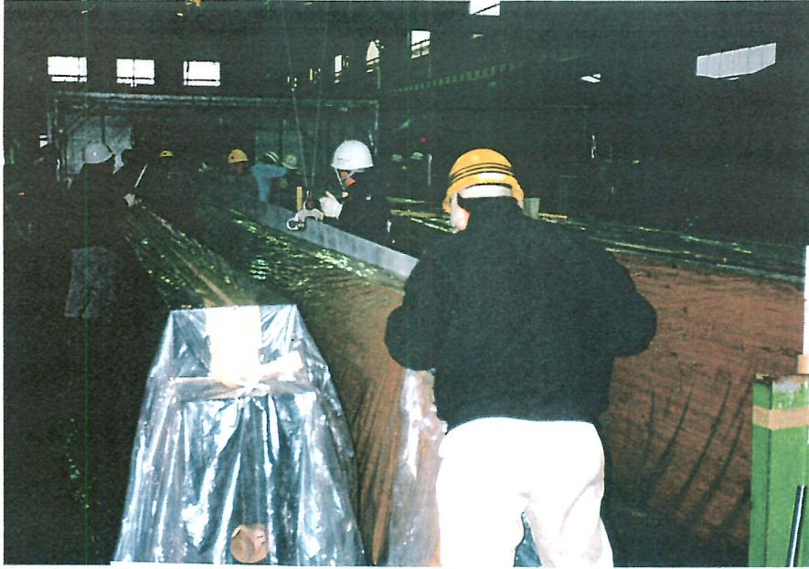
写-12 鋼板の挿入
