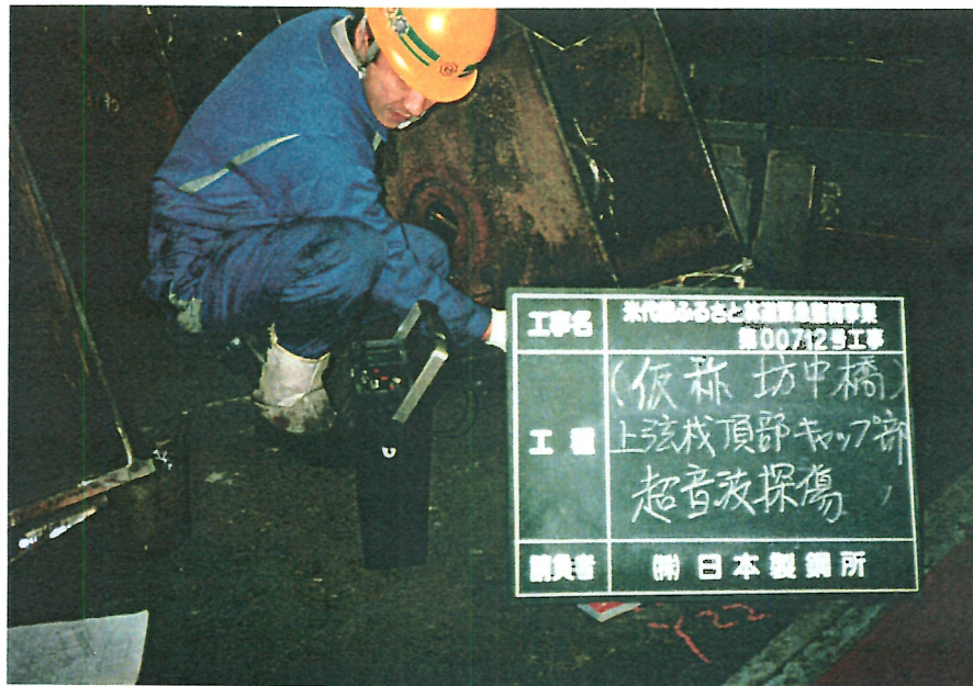
写-9 溶接部超音波探傷検査
