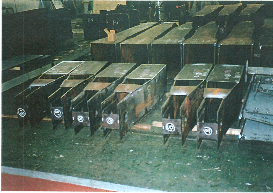
写-8 上弦材斜材用鋼箱部材
