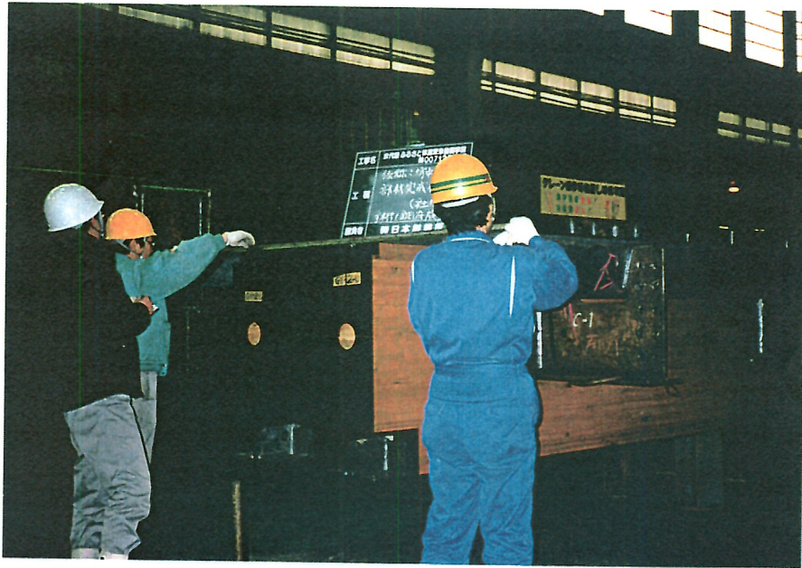
写-13 主桁ブロックの製作
