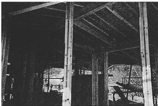
①施工中の軸組
