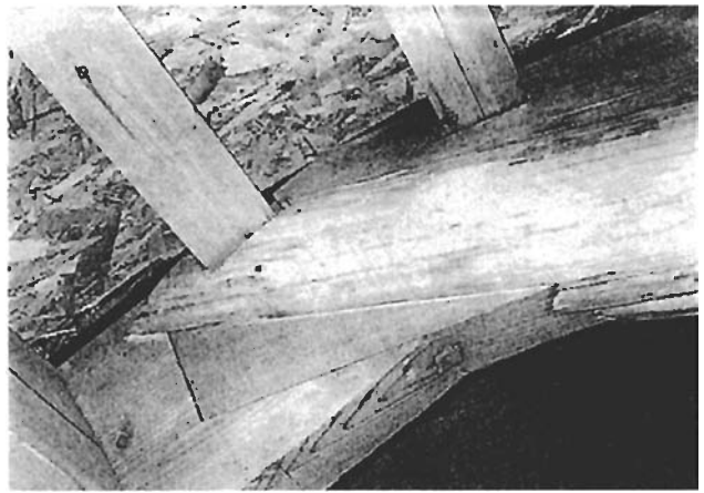
②電骨材の継手と丸太材の接合部分
