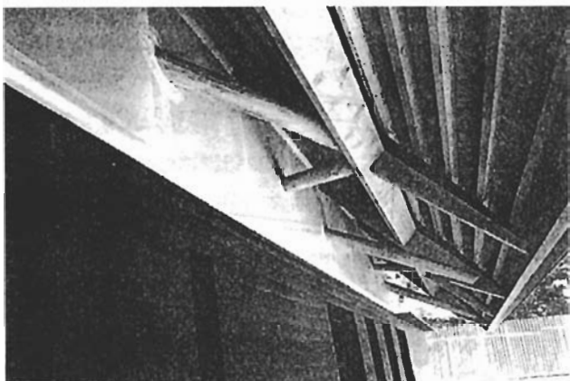
④サブ竜骨材の先端部で支えられた軒
