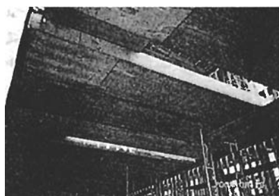
①構造用 LVL ボックスパネルによる2階床スラブの施工
