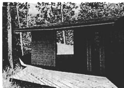
②独立耐力壁で支えられた深い軒
