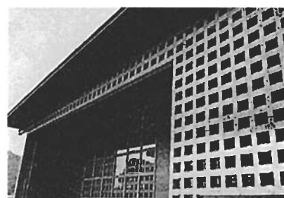
②けらばを支える LVL ウェブ釘打ち充腹梁の面格子垂れ壁
