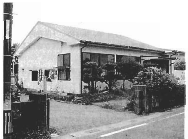
写真1. 改修工事後の梅北児童館
