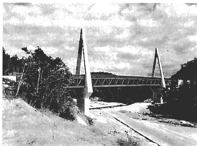
写真5. 完成時の用倉大橋
