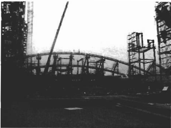
写真7. ドーム建方の内観
