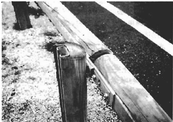
図4. フランスTERTU社の鋼材補強ガードレール
