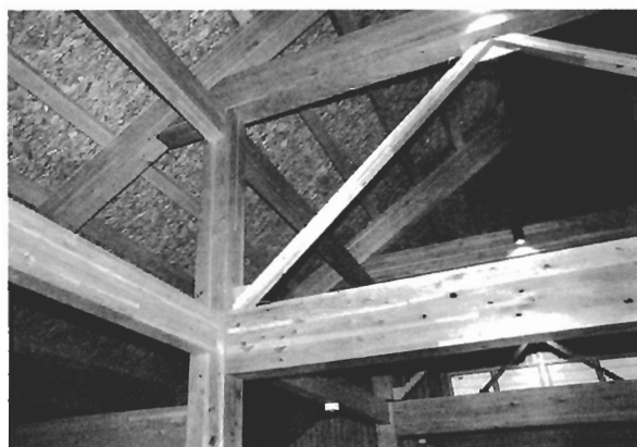
写真 U-3 集成材柱・梁の接合部
