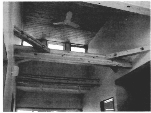
写真 2.4 集成材を用いた2階梁
