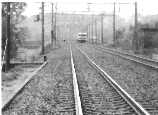
写真 2.6 線路が波打っている JR 上越線の田川地区と放置された列車。
