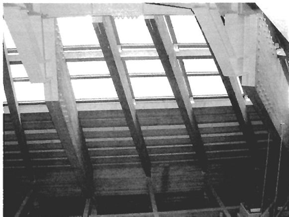
写真 D-3 屋根(集成材の接合部)
