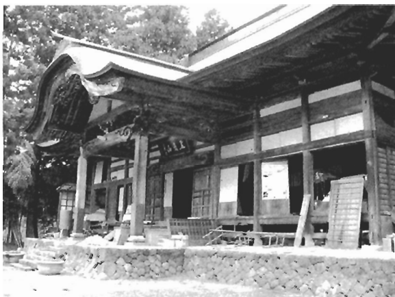
写真 N-15 近隣の神社(雨戸や障子ははずれているが、建物に大きな被害はない)
