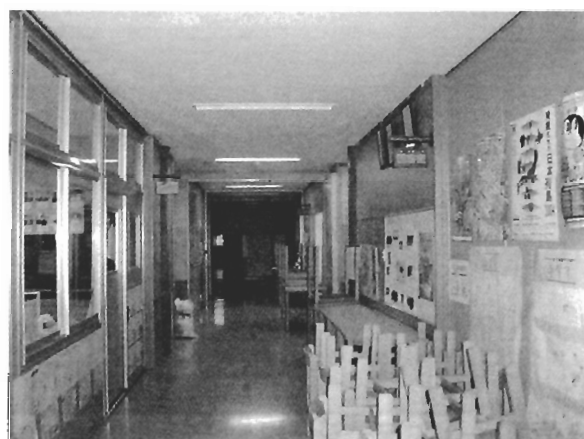
写真 Z-4 文教施設(Z)の1階廊下
