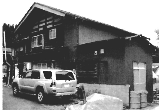
写真 5.2 No.5 外観 2（手前は増築部分）
