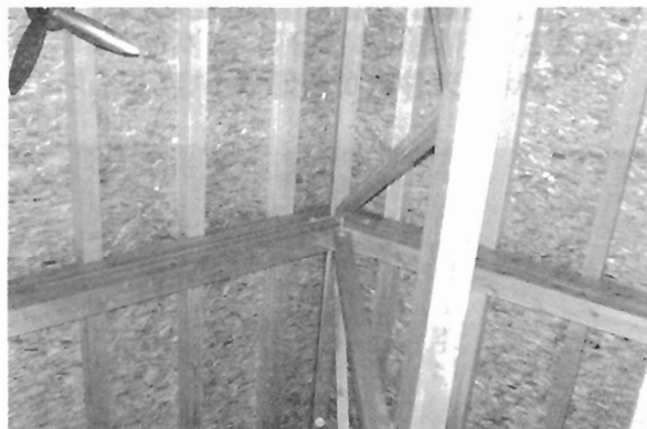
写真 U-4 天井部
