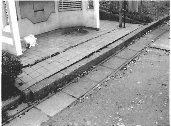
写真 L-8 近隣のごみ収集所(タイルのきれつ)
