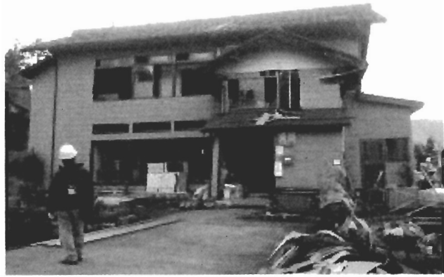
写真 2.31 リニューアルされたばかりの木造住宅の被害(元は船柵造りと思われる)
