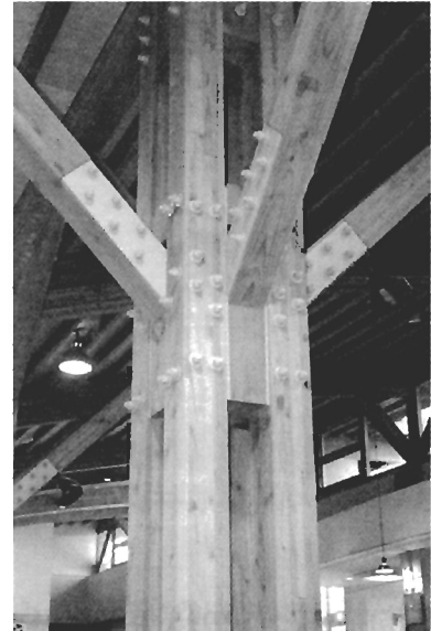
写真 C-4 集成材柱の接合部
