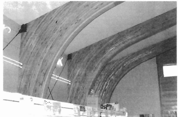
写真 P-2 店舗内部
