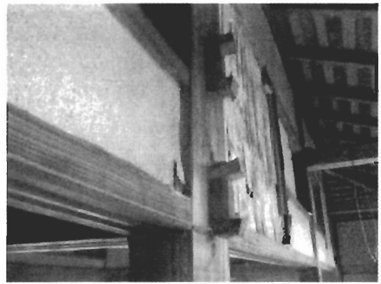
写真 2.17 大黒柱と差し鴨居のモーメント抵抗接合部
