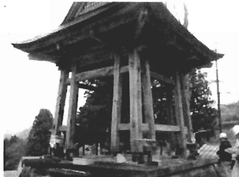
写真 2.26 鐘樓足下の蟻害による補修状況
