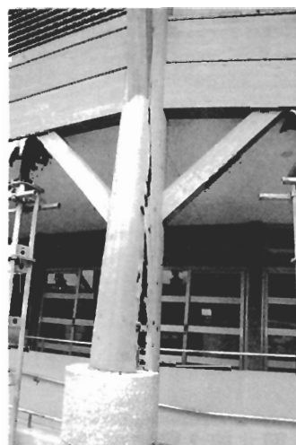
写真 N-2 玄関外側の集成材円柱
