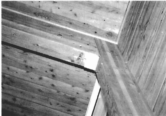
写真 L-3 ホール(集成材柱・梁接合部)
