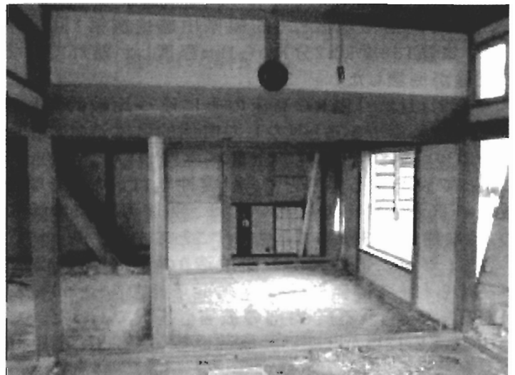
写真 2.16 船柵造りの住宅の1階に使われている立派な差し鴨居と無傷な小壁
