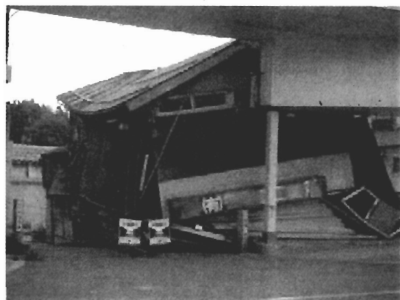
写真 16 倒壊した店舗併用型住宅
