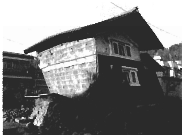
写真 26 大破した土蔵
