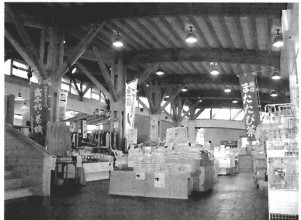
写真 C-2 内部(4本の集成材を組合せた柱と湾曲集成材の梁)
