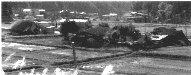
写真 20 東吉谷付近に集中している倒壊住戸
