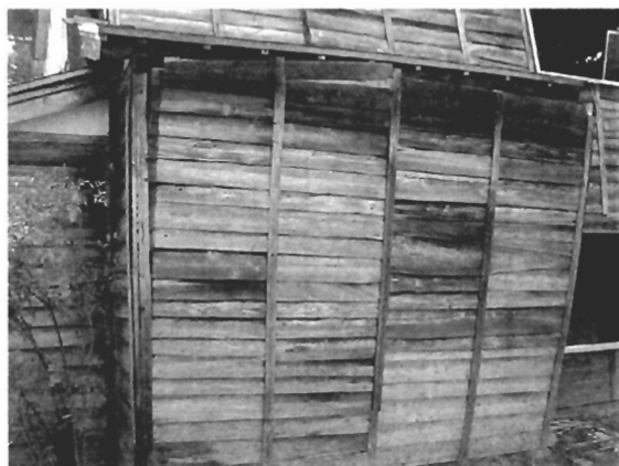
図4 床の間の張り出し部分
