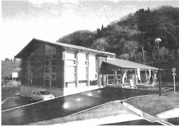
写真 E-1 旧入広瀬村の店舗兼事務所(E)
