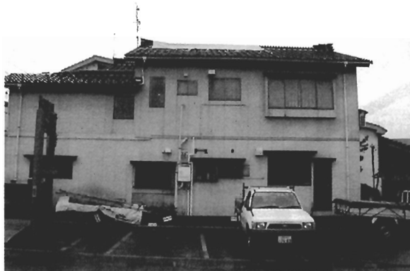
写真 Q-8 近隣の住宅(屋根瓦の落下)
