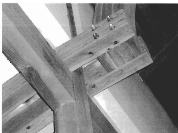
写真 A-4 多目的ホール棟 2階(集成材の接合部)
