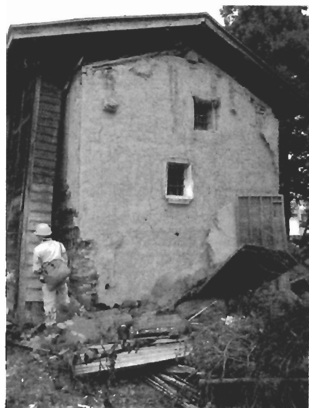
写真 2.22 土蔵柱の蟻害状況
