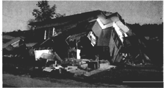
写真 30 田麦山地区の倒壊家屋
