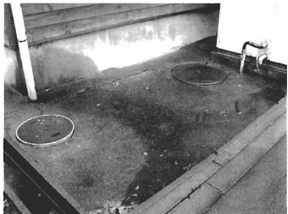
写真 P-4 店舗西側犬走り部のきれつ(左側のマンホールが浮き上がっている)
