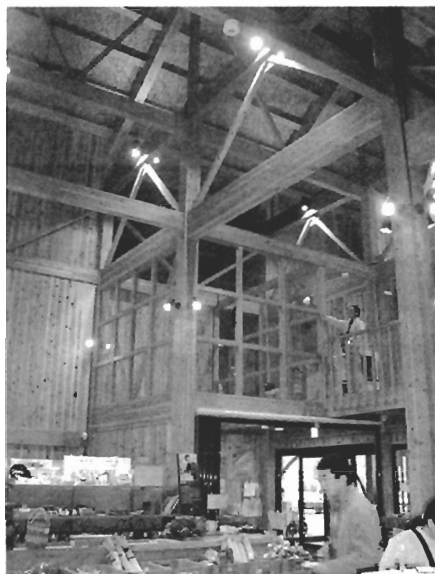
写真 U-2 店舗の吹き抜け部
