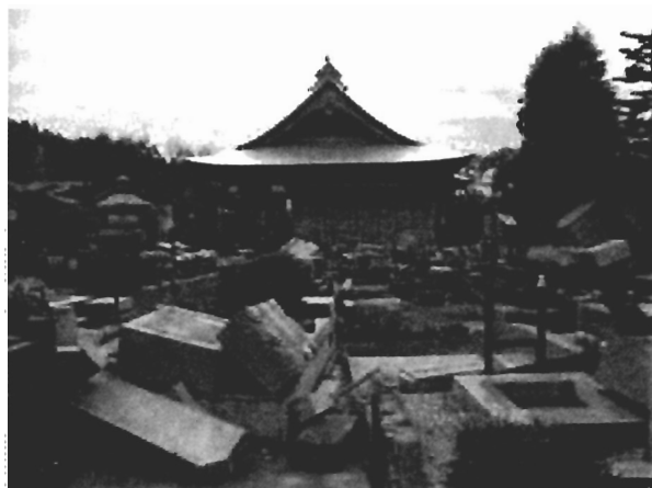
写真 25 墓石の転倒（画面右が西）
