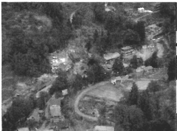
写真3 長岡市蓬平地区の地滑り現場と 滑り落ちそうな家屋
