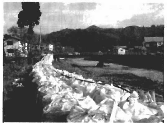
写真 2.1 土嚢で堤防がかさ上げされた竜光地区を流れる芋川
