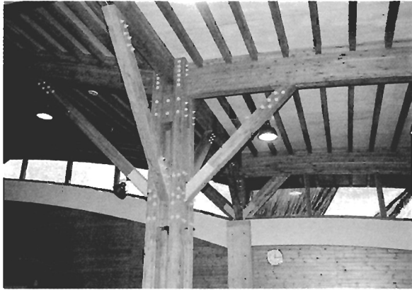
写真 C-3 内部(外壁部の RC の柱(奥))
