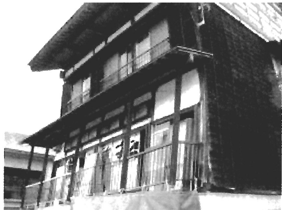
写真 2.12 RC高床式3階建て伝統構法住宅(近景)
