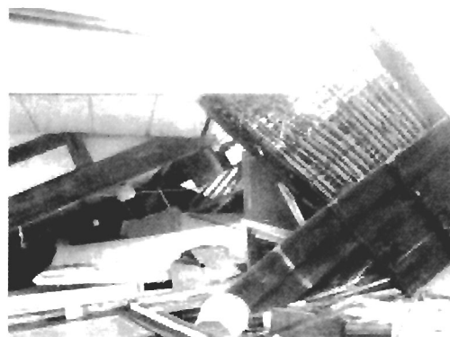
写真 2.4 全壊した船柵造り風の別棟。葦のような植物をそのままの断面で木舞とした独特の土塗り壁であった。
