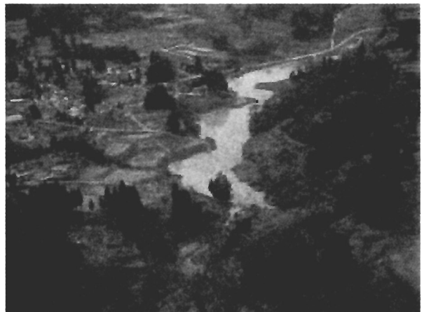
写真10 土砂で堰き止められた奥内川
