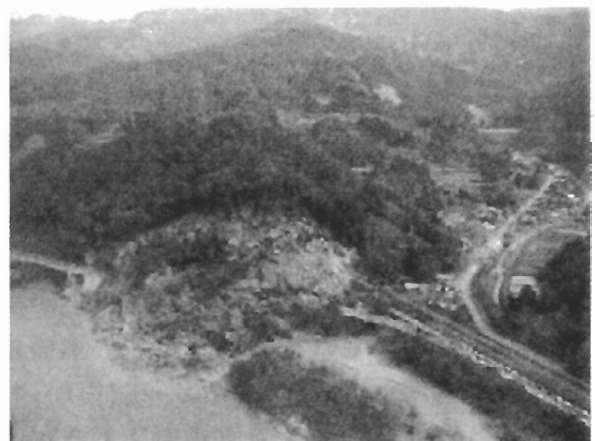
写真4 長岡市妙見町の大規模土砂崩落 現場（母子3人遭難現場）
