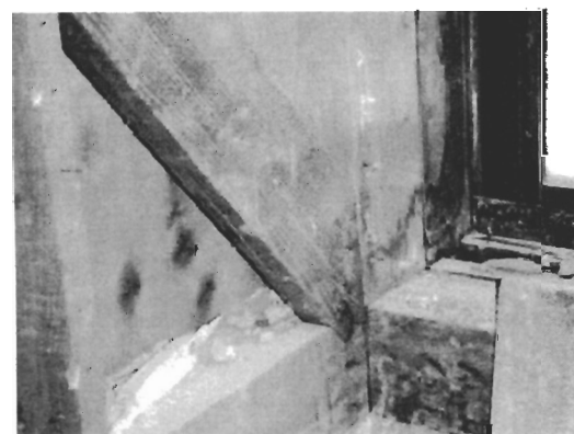
写真 11.4 風呂場壁内 (筋かいの納まり)
