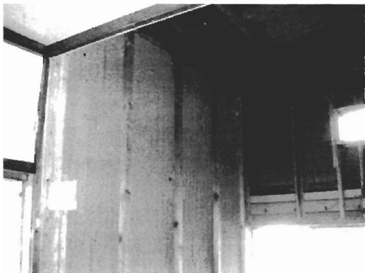
写真 12.10 風呂場壁内の様子
