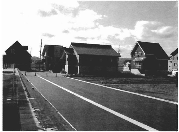
写真 B-6 近隣の RC 高基礎の住宅
