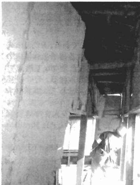
写真 2.15 2階が大きく傾いた船柵造りの住宅の2階内部における土壁の被害状況。屋根梁は直径30cm以上の丸太を使用。
