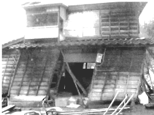
写真 2.2 在来木造 2 階建て倉庫
