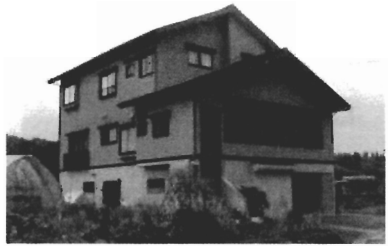
写真 2.13 RC高床式現代風3階建て住宅
