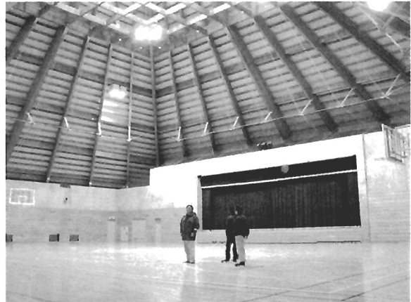
写真 D-2 内部(集成材構造の屋根)
