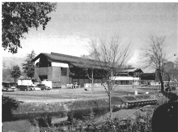
写真 A-1 旧六日町の店舗兼事務所
