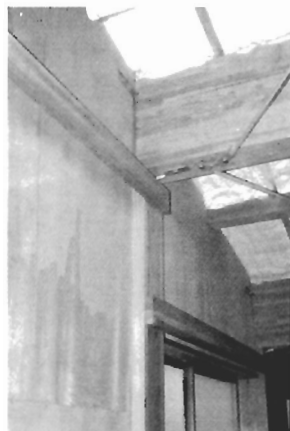
写真 Q-4 2階倉庫(集成材梁の接合部)
