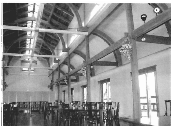
写真 A-3 多目的ホール棟 2階
