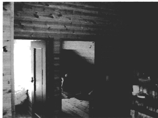
写真 4.2 内部の様子 (2階)
