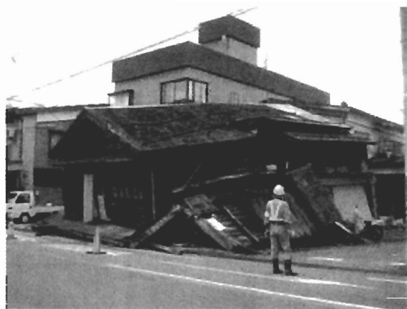
写真 17 倒壊した比較的古い構法の住宅
