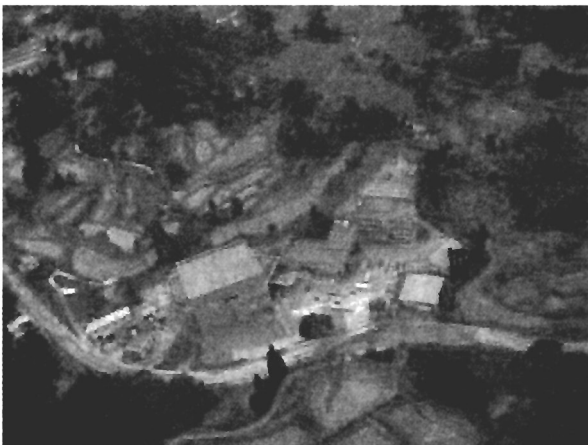
写真9 土砂崩壊箇所にて囲まれた山古志村役場
