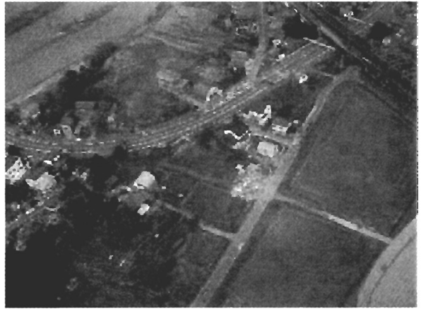
写真8 旧堀之内町郊外の倒壊家屋
