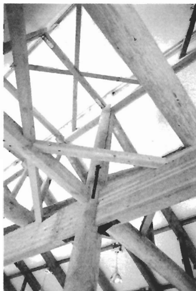
写真 Z-3 ベイマツ丸太と集成材の接合部
