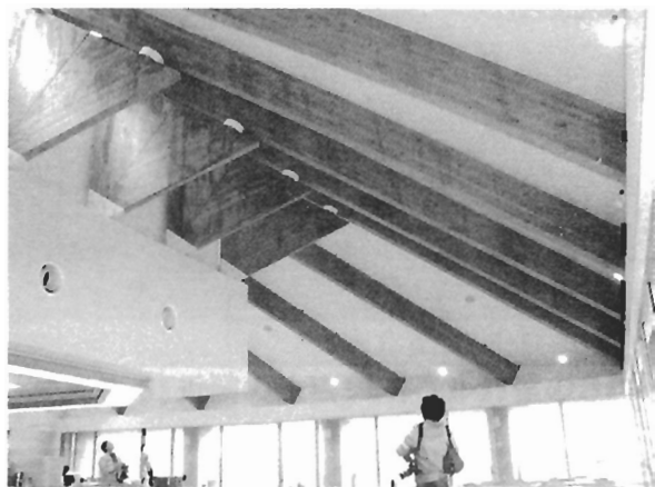
写真 R-2 内部
