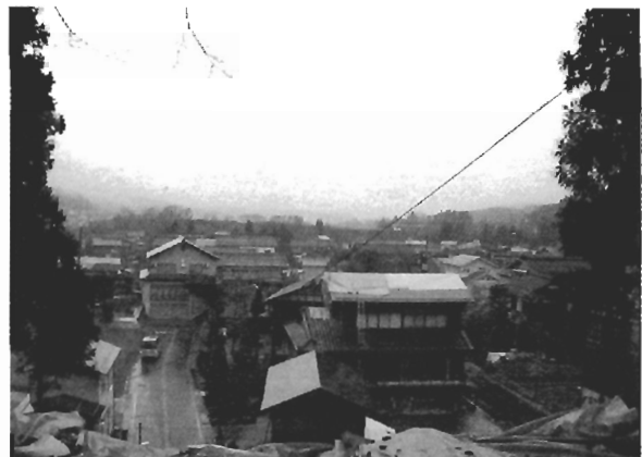
写真 S-14 近隣の住宅(屋根瓦が落下した住宅が見られる)
