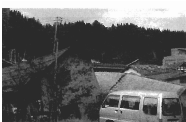
写真 23 軒並み倒壊した家屋が並ぶ川口町役場付近
