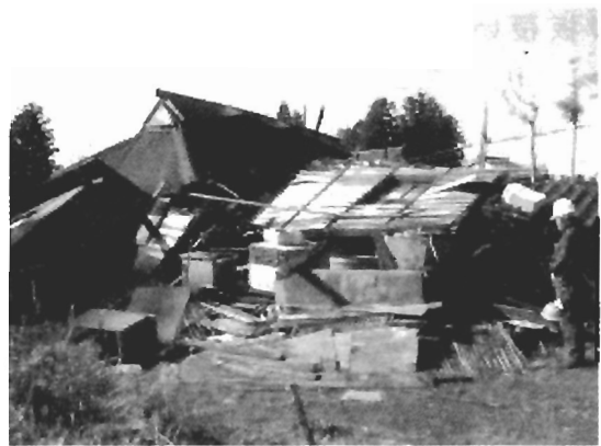
写真 2.18 完全に倒壊した農家
