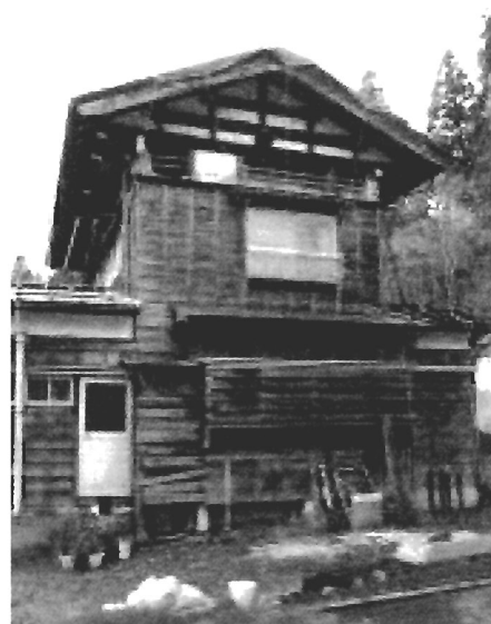
写真 2.3 伝統的な 2 階建て船柵造りの住宅
