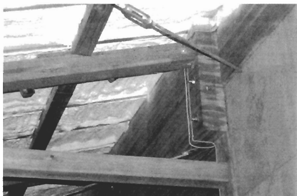
写真 Q-5 2階倉庫(集成材の接合部)
