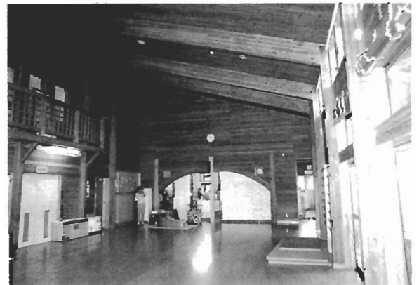
写真 L-2 ホール吹き抜け部
