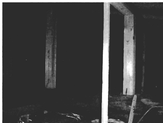
写真 13.5 小屋裏の様子
