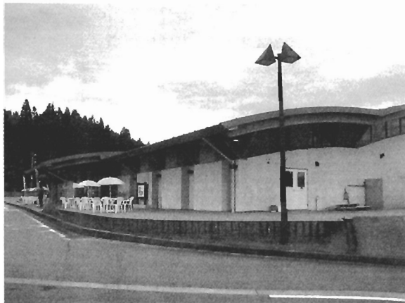
写真 C-1 旧小出町の店舗兼事務所(C)(建物の外周部は RC 造)
