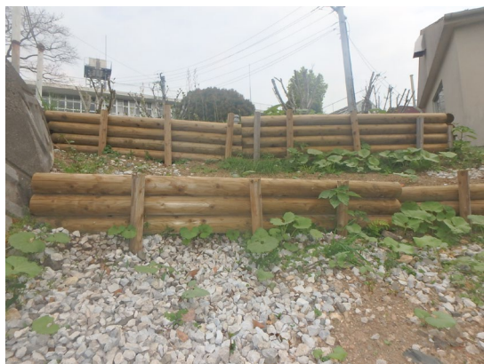
写真4 高知県産のスギを使用した土留め（四国支所）
