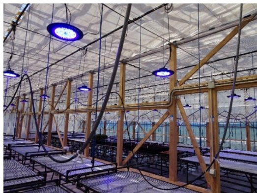
写真6 構造体に国産材を利用した木造温室の内観（林木育種センター）
