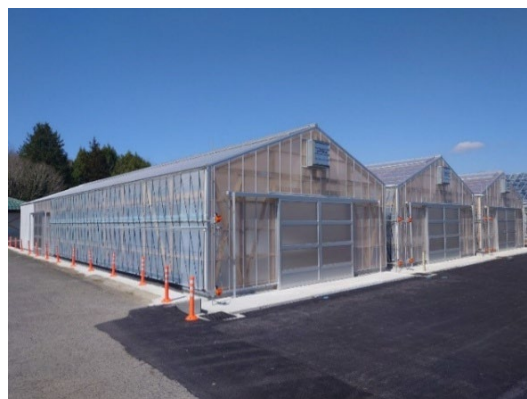
写真7 構造体に国産材を利用した木造温室の外観（関西育種場）
