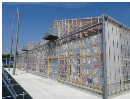
写真5 構造体に国産材を利用した木造温室の外観（林木育種センター）
