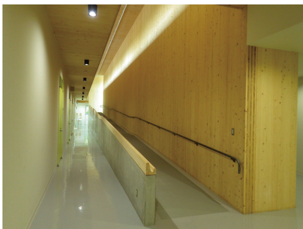
CLTを使った共同実験棟の内部
