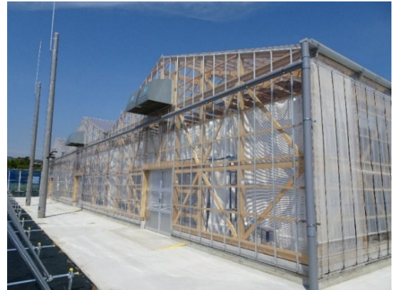
写真5 構造体に国産材を利用した木造温室の外観（林木育種センター）
