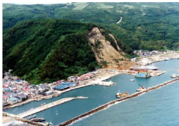
写真-3 北海道南西沖地震時の大規模崩壊 (撮影：落合博貴)
