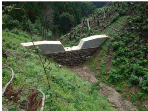
H26に完成した谷止工
