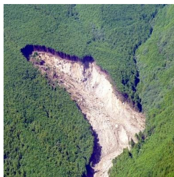
水害：豪雨、洪水による埋没、水没、流失などの損害
