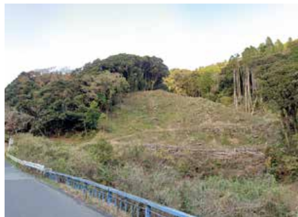
復旧作業後の様子
