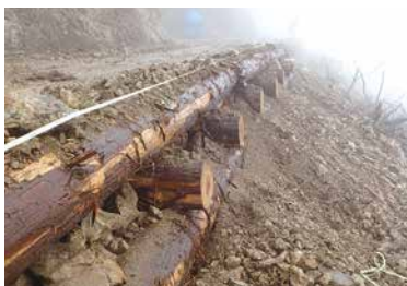
写真4 路面補強工の実施状況
