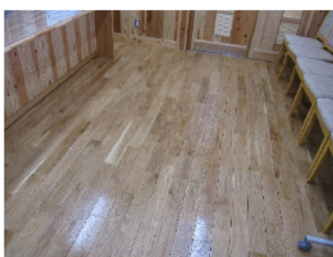
写真2 コナラ単層フローリングの施工例 6)
