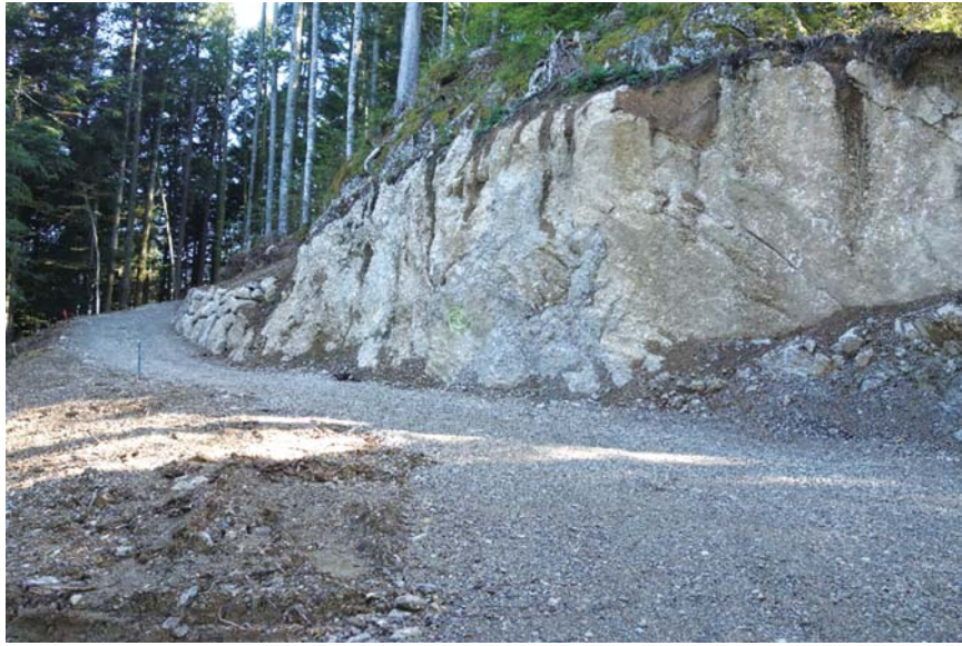
写真 2. 敷設された林道 土砂流出を防ぐために厚さ 60cm の砂利を敷き詰めている。
