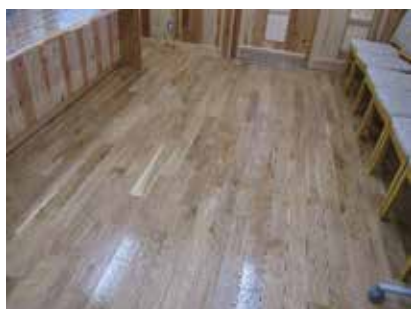
写真2. 試験施工された コナラフローリング 島根県中山間地域研究センター 後藤崇志氏提供
