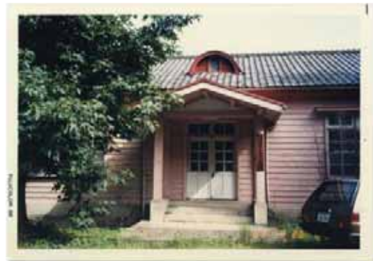
岡山試験地庁舎玄関（1988年8月下旬著者撮影）
