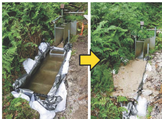
図1 流量観測用の堰とその下流側に設置した水槽。左が土砂を取り除いた直後の様子で、右が満砂状態の様子。
