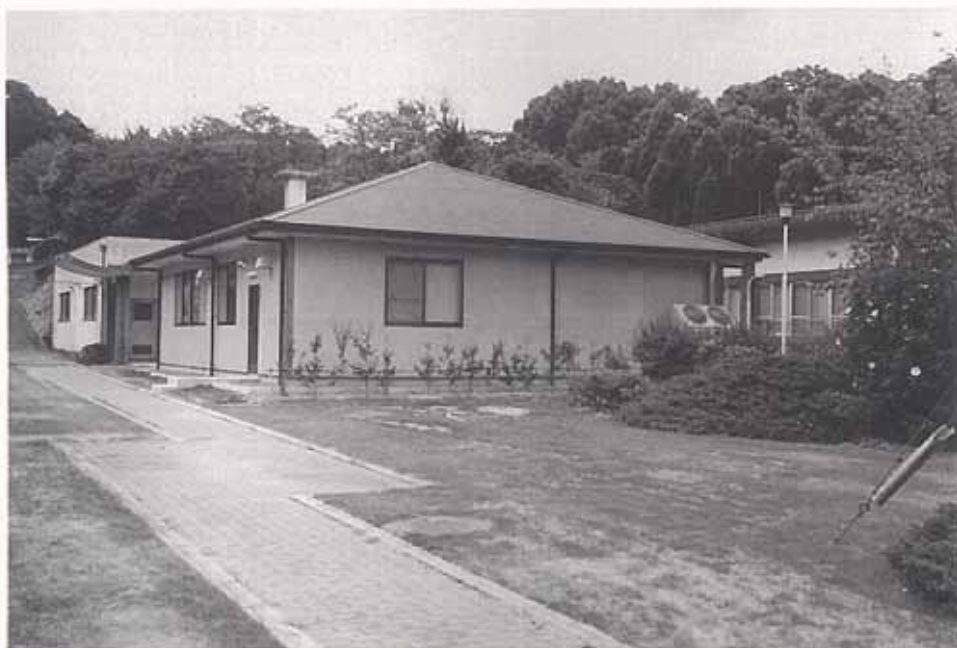
新築された森林微生物生理実験棟
