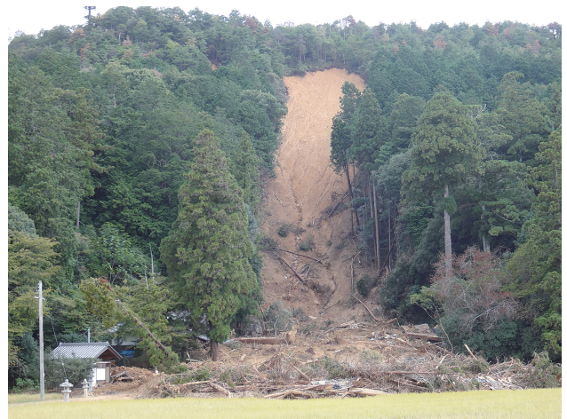
滋賀県栗東市で発生した土砂災害
