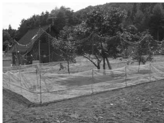
写真1-2 防護柵設置状況
