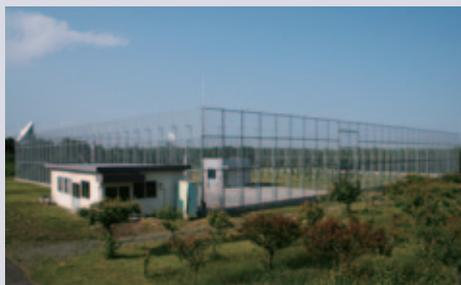
「特定網室」は、実験室や閉鎖系温室で試験した遺伝子組換え林木を、より自然環境に近い環境で育てて評価するための温室で、花粉を媒介する昆虫の侵入を防止するため、窓に網を張っています。
