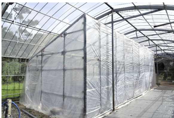
写真3. 足場用資材利用ハウスの完成写真
