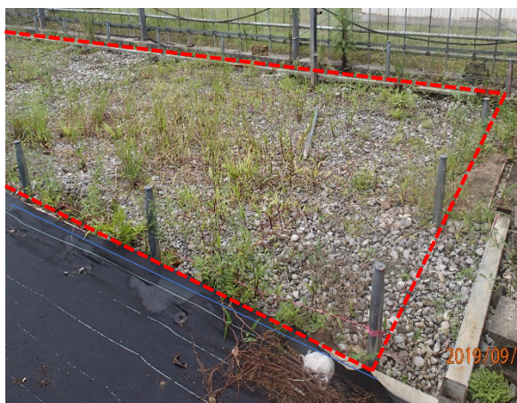
写真2.単管杭打ち込み後（単管杭打ち込み箇所は、赤点線で結んで示した）
