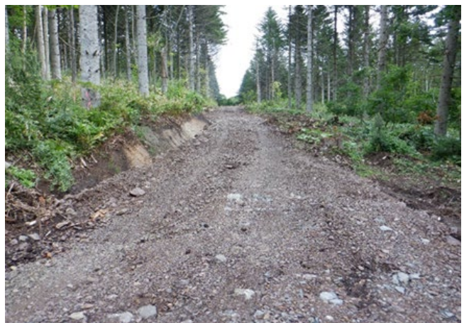
国有林採種園内に整備した作業路 （令和 5 年度実施）
