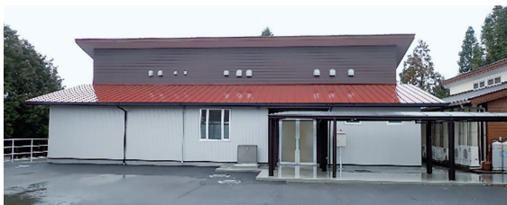
写真-1 林木遺伝資源長期保存実験棟
