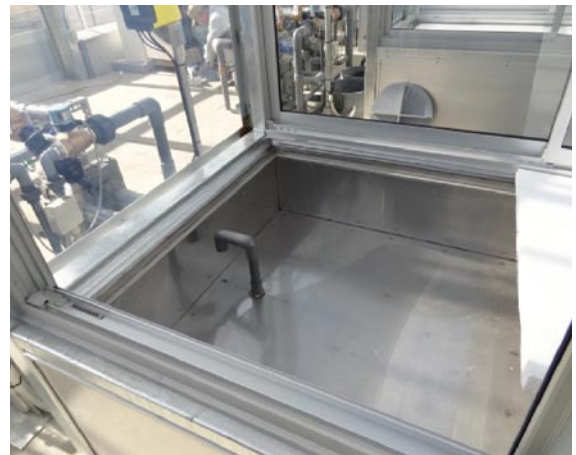
写真 2 プール式灌水・施肥設備
