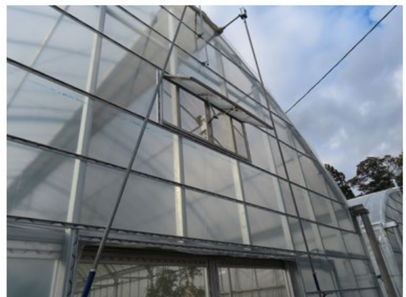
写真9 妻面開口部(小窓)
