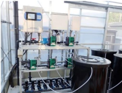
写真10 液体肥料自動供給システム
