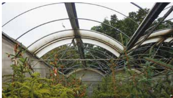
写真2. Coillteの施設内採種園の開閉式屋根
