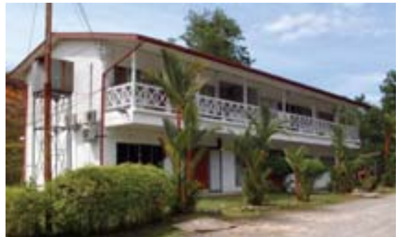
写真－2 SAFODA キナルートの本館 実験室は 1 階左側
