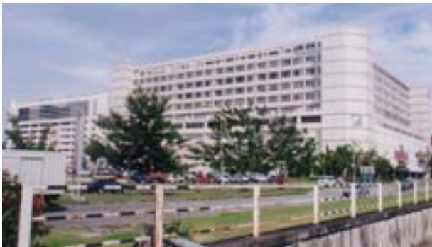
写真－1 SAFODA 本部が 5 階に入居している コタキナバル市内のショッピング センタービル
