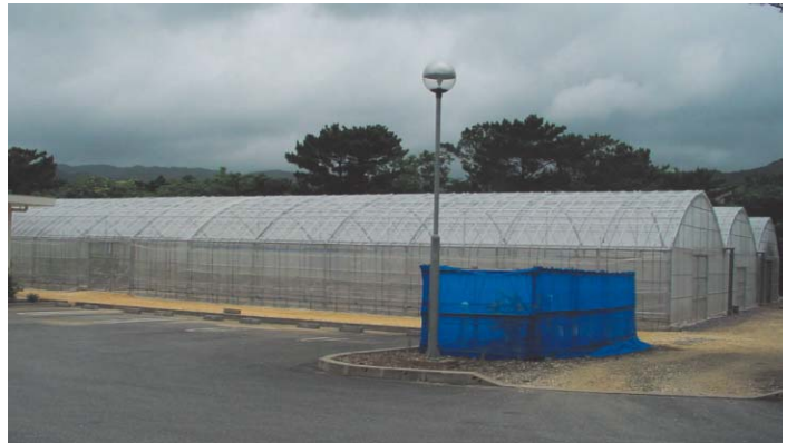
交配実験ハウスの全景
