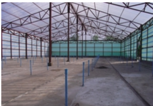
写真5 建設中の育苗施設
