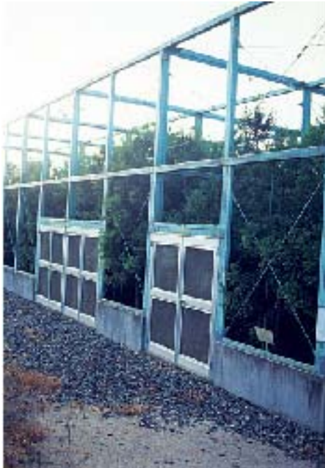
写真-2 網室設置状況
