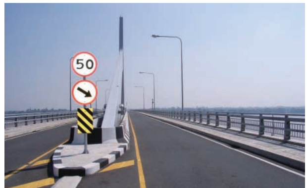
タイ・ラオスの国境、メコン川にかかる第二友好橋
