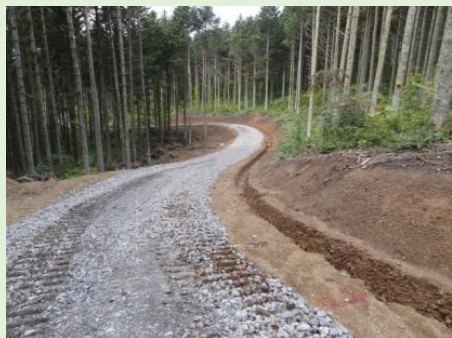
路面に敷均した砂利と側溝
