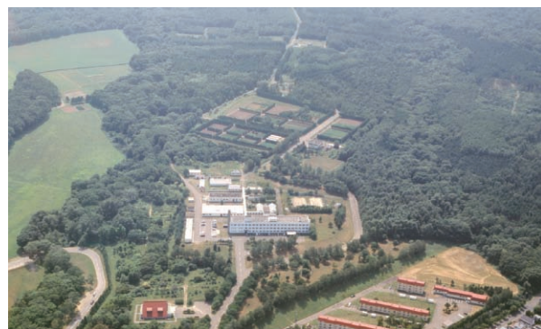
写真-5 2008年頃の羊ヶ丘の庁舎の周辺 庁舎の周辺は元の森と区別がつかないくらい木々が成長した
