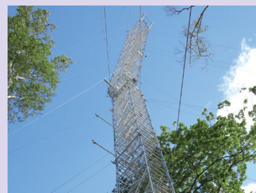
フラックス観測タワーの損壊状況
