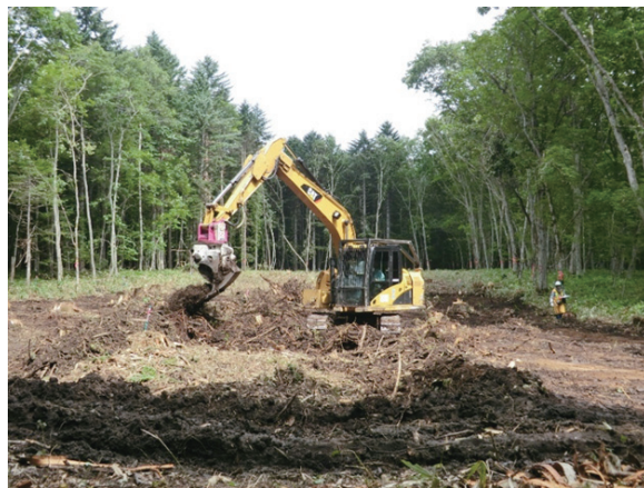
写真3 油圧ショベルを利用した地がき作業
