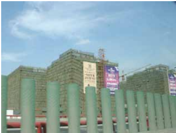
写真-1 高層マンションの建設現場
