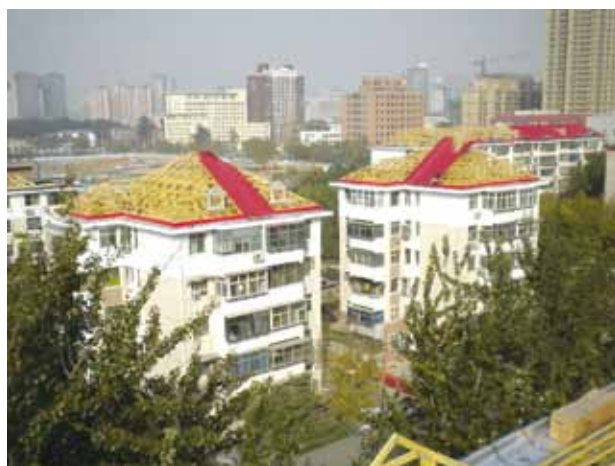
写真-3 木製トラスによる旧公営住宅・社宅のリルーフィング（写真提供：Canada Wood）
