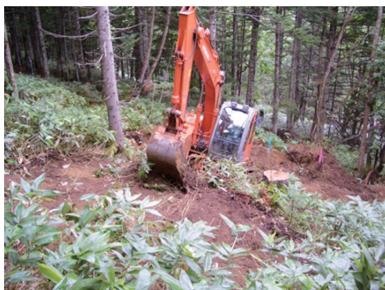
図4 小面積樹冠下地がき作業
