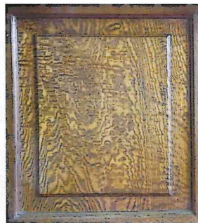
写真4 道庁赤レンガ庁舎腰板壁(部分)
