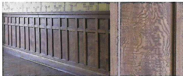
写真2 旧庁舎腰板壁
