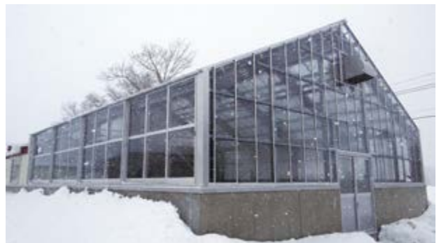
完成した温室の外観
