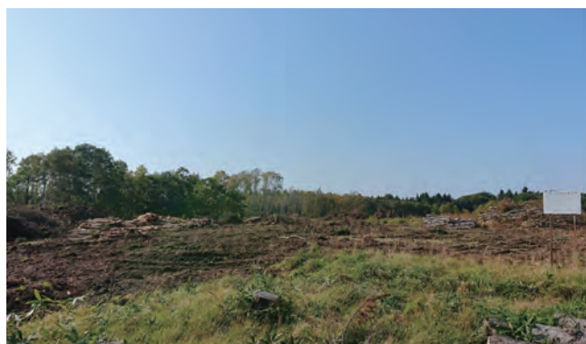
写真-4 復旧の状況
