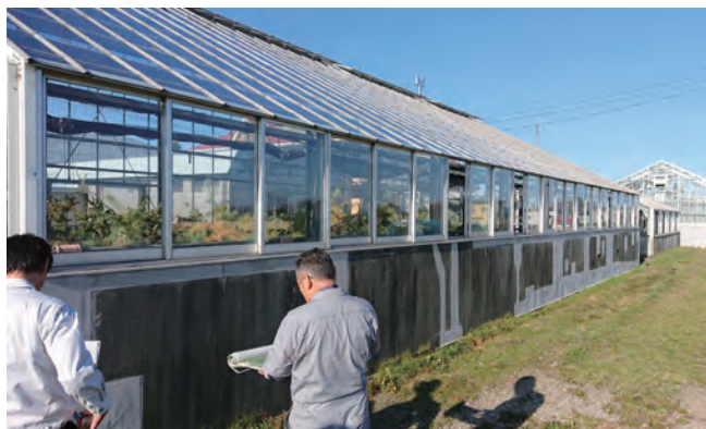
写真-1 温室の腰壁等の修繕
