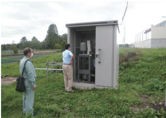
灌水施設の修繕
