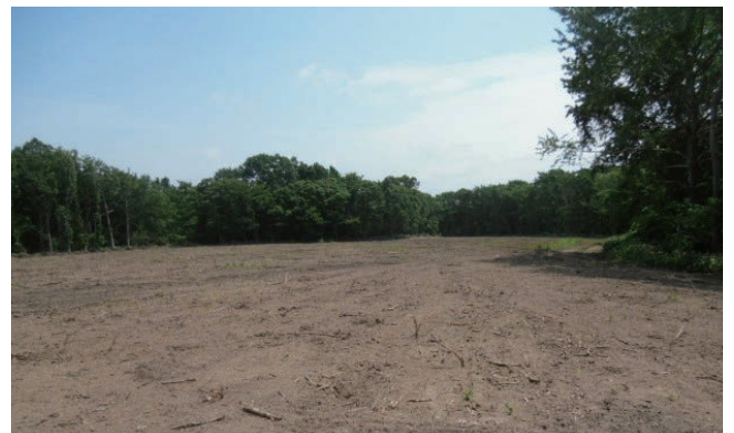
客土敷設・整備 2
