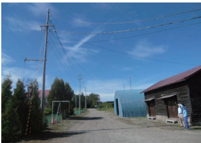
傾斜した電柱の交換
