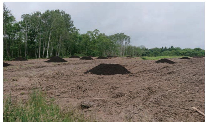
客土敷設・整備 1
