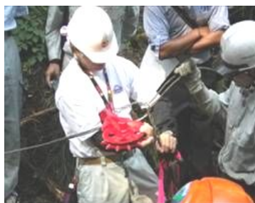
写真2 ジグザグ滑車の通過状況
