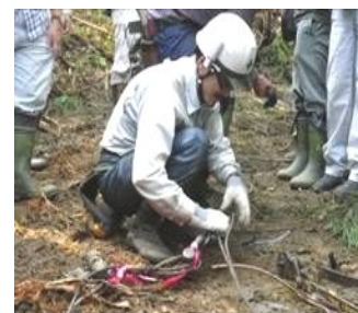
写真3 連結部のワイヤ加工実演
