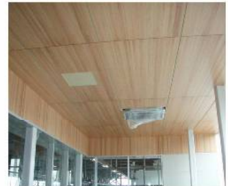
②待合室天井
