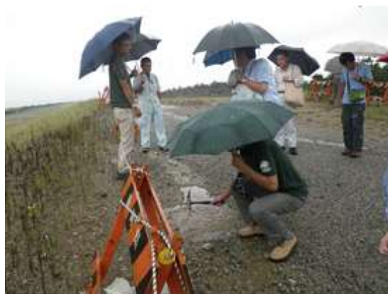
（海岸防潮堤 浜松市南区西島町）
