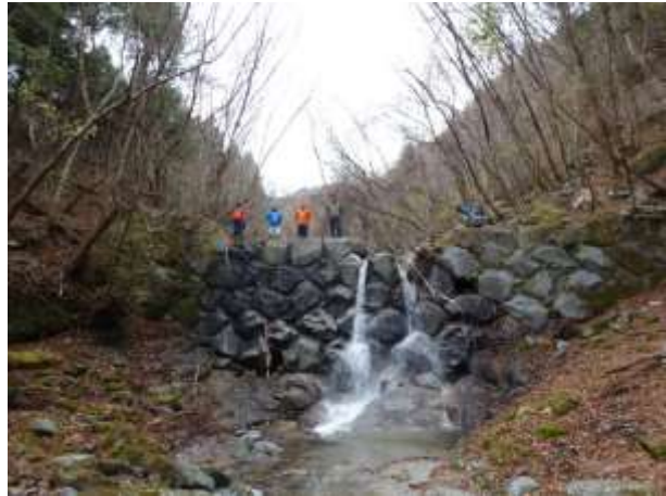
写真1 金山沢3号えん堤 1927年竣工 （足柄上郡山北町世附）
